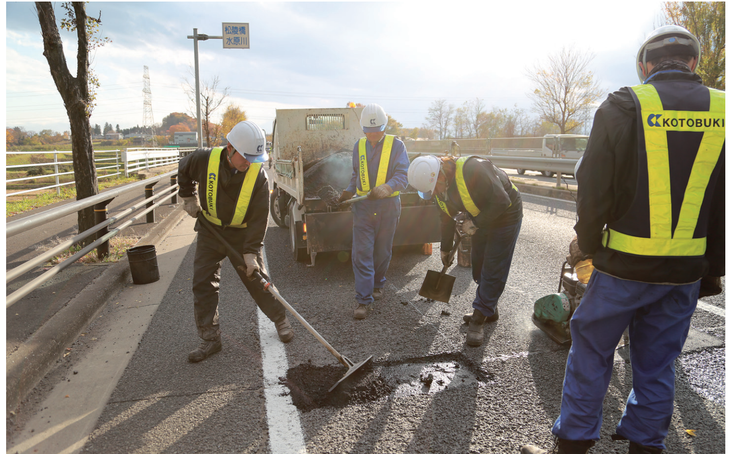
道路上にある小面積の舗装修繕作業の様子。通行中の車両・人への安全確保に対する配慮を欠かさない。彼らのこのような作業の積み重ねで、私たちは道路を快適に走れるのだ
