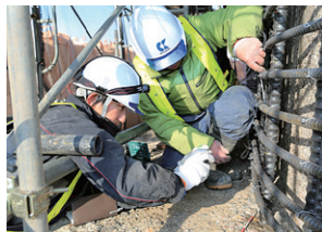
橋梁補修の出来形管理(精度を評価し技術の度合いを管理すること)
