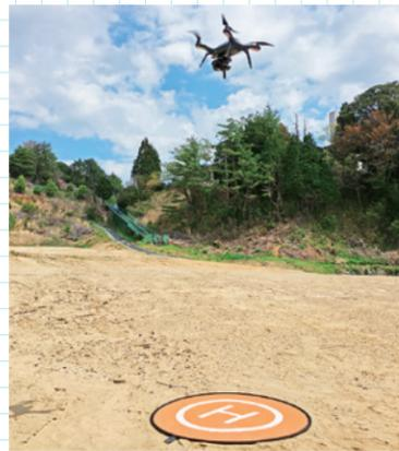
ドローンによる3次元測量を行い、造成工事を撮影。高所撮影により広範囲のデータを取得できる
