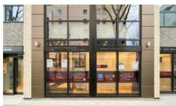
福島駅東口から徒歩5分。AXCビルの道路向かい
