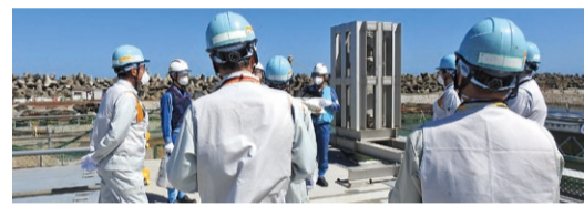
放水立坑放射線モニタの確認状況
