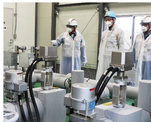
緊急遮断弁を確認する様子
