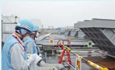
1号機原子炉建屋から撤去されたガレキが入っている容器の確認
